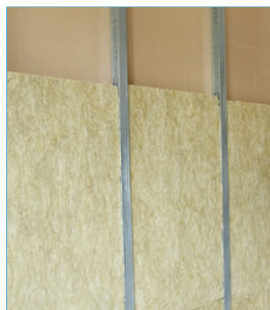
Termarock® 50 Feuerschutzplatte Euroklasse A1, Mindestrohdichte 50 kg/m 3 , Wärmeleitfähigkeit \lambda = 0,035 W/(m·K)
