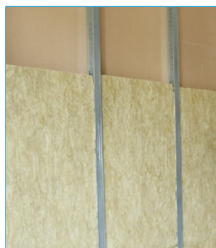
Termarock® 40 Feuerschutzplatte Euroklasse A1, Mindestrohdichte 40 kg/m 3 , Wärmeleitfähigkeit \lambda = 0,035 W/(m·K)
